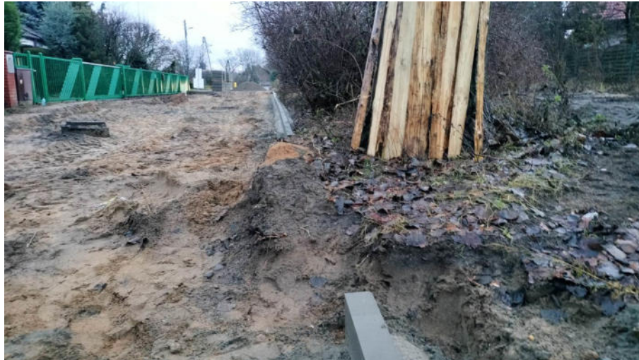
Przerwa w ułożonym oporniku betonowym na ławie na odcinku prostym w celu wykonania lokalnego zwężenia nawierzchni (ułożenie opornika z zastosowaniem małych promieni w sąsiedztwie kolizji z zielenią wysoką) (2023).
