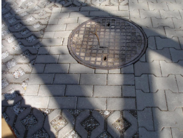
Wybruk 0,8x1,2m żeliwnego wjazdu studzienki kanalizacji sanitarnej z kostki betonowej typu „Cegiełka” prostopadle do kierunku jazdy na styku części jezdnej nawierzchni z płyt ażurowych z częścią pieszą z kostki typu „Behaton” (2023).
