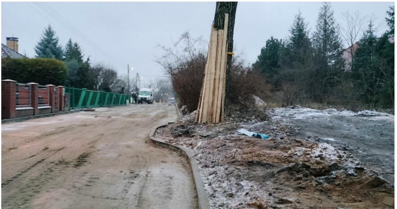
Następny etap robót - ułożona na podbudowie z mieszanki niezwiązanej (kruszywa łamanego zastabilizowanego mechanicznie) warstwa podsypki na której po wyrównaniu ułożone zostaną płyty ażurowe i kostka betonowa (2024).
