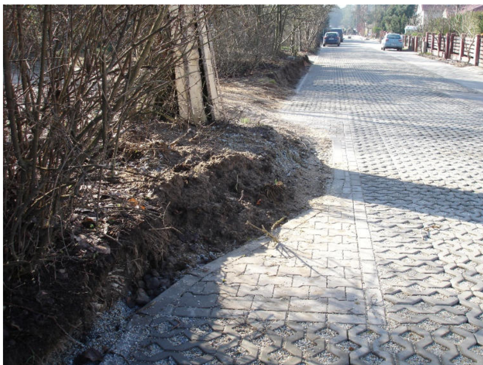
Ułożenie części jezdnej nawierzchni z betonowej kostki typu „Behaton” w miejscu zwężenia powstałego poprzez istniejącą zieleń wysoką (2024).
