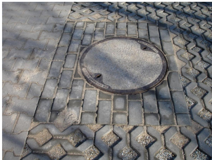
Wybruk 1,0x1,2m betonowo-żeliwnego wjazdu studzienki kanalizacji sanitarnej z kostki betonowej typu „Cegielka” zgodnie z kierunkiem jazdy na styku części jezdnej nawierzchni z płyt ażurowych z częścią dla pieszych z betonowej kostki typu „Behaton” (2023).
