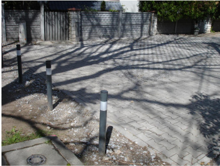
Przykład usytuowania słupków wygradzających z pryzmatyczną taśmą odblaskową na końcu nowej nawierzchni ażurowej ulicy w celu uniemożliwienia dalszego przejazdu po wprowadzeniu Stałej Organizacji Ruchu.
