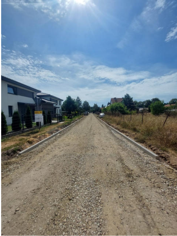
Następna faza robót - rozkładanie podbudowy z kruszywa łamanego oraz zagęszczanie jej warstwami (2024).
