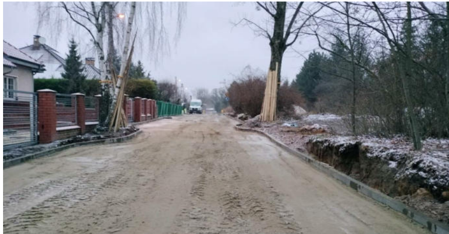
Przykład ułożonych oporników betonowych na odcinku prostym z lokalnymi obustronnymi przewężeniami (z zastosowaniem małych promieni łuków) w celu bezpośredniego zabezpieczenia zieleni wysokiej po obu stronach pasa drogowego (2023).
