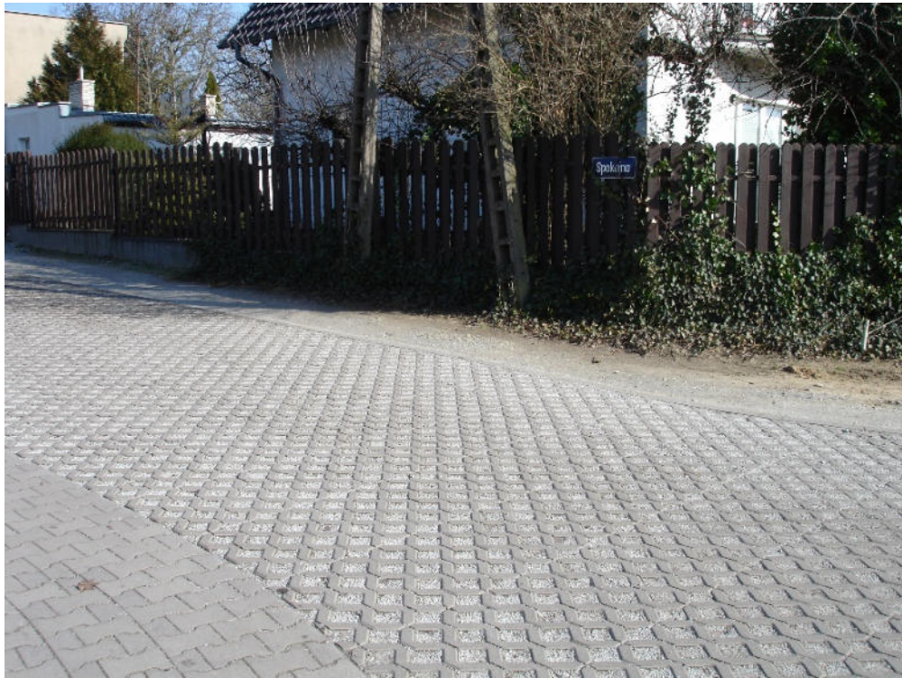
Przykład przejścia z łuku R-5m w prostą nawierzchni ażurowej. W przekroju także jednostronna nawierzchnia betonowa z kostki typu „Behaton” dla ruchu pieszego oraz pobocze z kruszywa łamanego szerokości 0,75m (2024).
