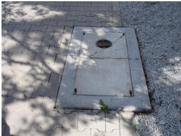
Ułożenie nawierzchni części pieszej z betonowej kostki typu „Behaton” na styku z telekomunikacyjną studzienką rewizyjną - betonowa rama żelbetowa studzienki nie wymaga dodatkowego ułożenia wybruku z kostki typu „Cegielka” (2023).
