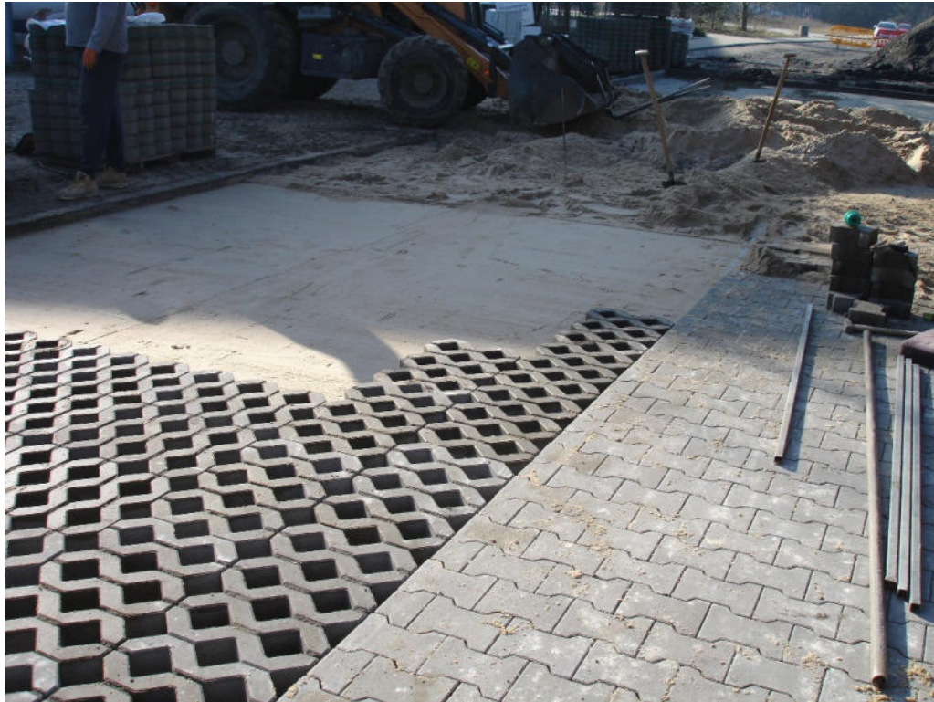
Przedostatni etap robót - układanie elementów prefabrykowanych nawierzchni (górna warstwa) - płyty ażurowe i kostka betonowa na wyrównanej warstwie podsypki o zróżnicowanej grubości 3-5cm (2024).
