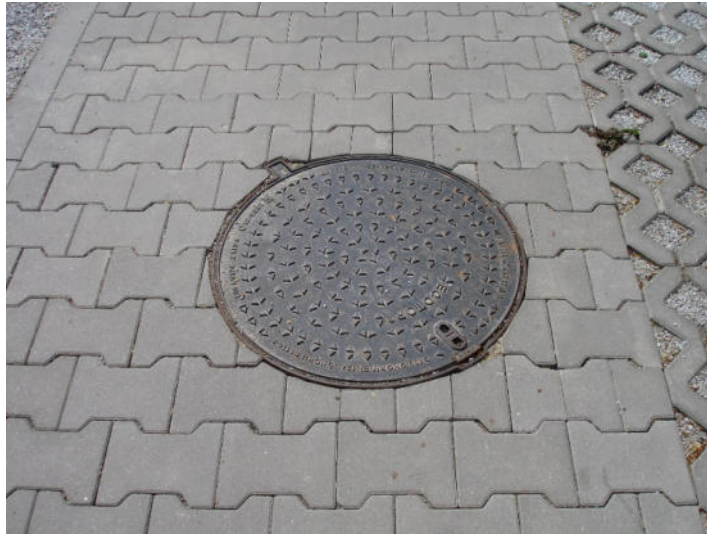
Obrukowanie kostką typu „Behaton” żeliwnego wjazdu studzienki kanalizacji sanitarnej w części nawierzchni ażurowej ciągu przeznaczony dla pieszych (2023).
