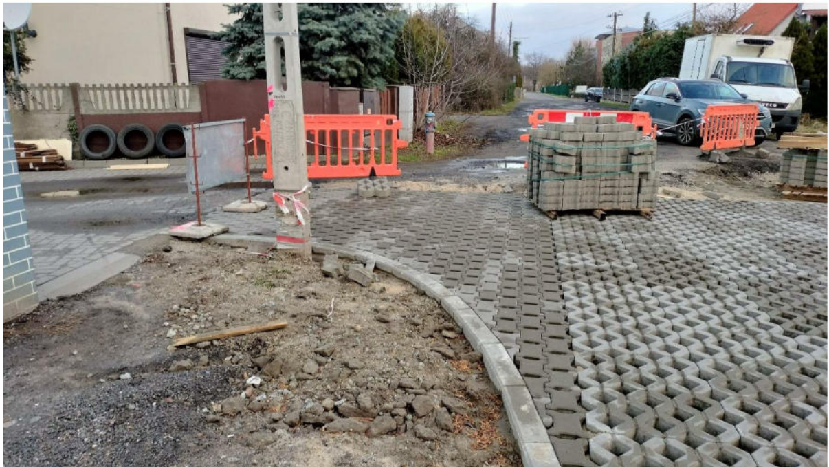
Ułożenie płyt ażurowych nowej nawierzchni w miejscu łuku zjazdu bądź skrzyżowania z wykorzystaniem przepuszczalnej kostki betonowej typu „Eko-Behaton” (2023).
