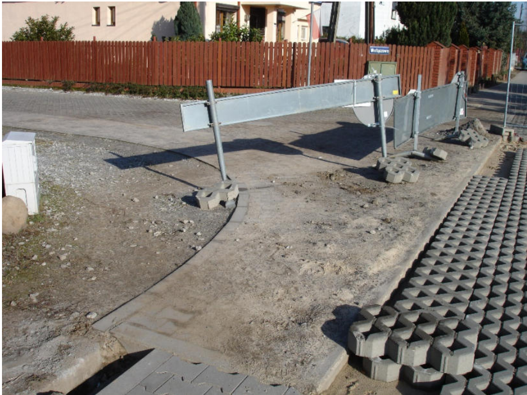
Ułożenie płyt ażurowych nowej nawierzchni na styku istniejącej nawierzchni z płyt ażurowych zakończonej opornikiem betonowym (rejon skrzyżowania ul. Wrotyczowej z ul. Umultowską) (2024).
