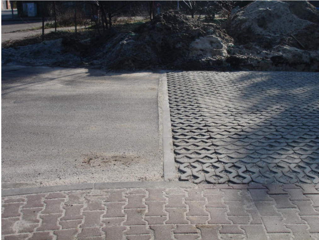
Przykład połączenia nowej nawierzchni ażurowej z istniejącą bitumiczną. Dodatkowo ułożony na styku nawierzchni opornik betonowy na ławie (2024).
