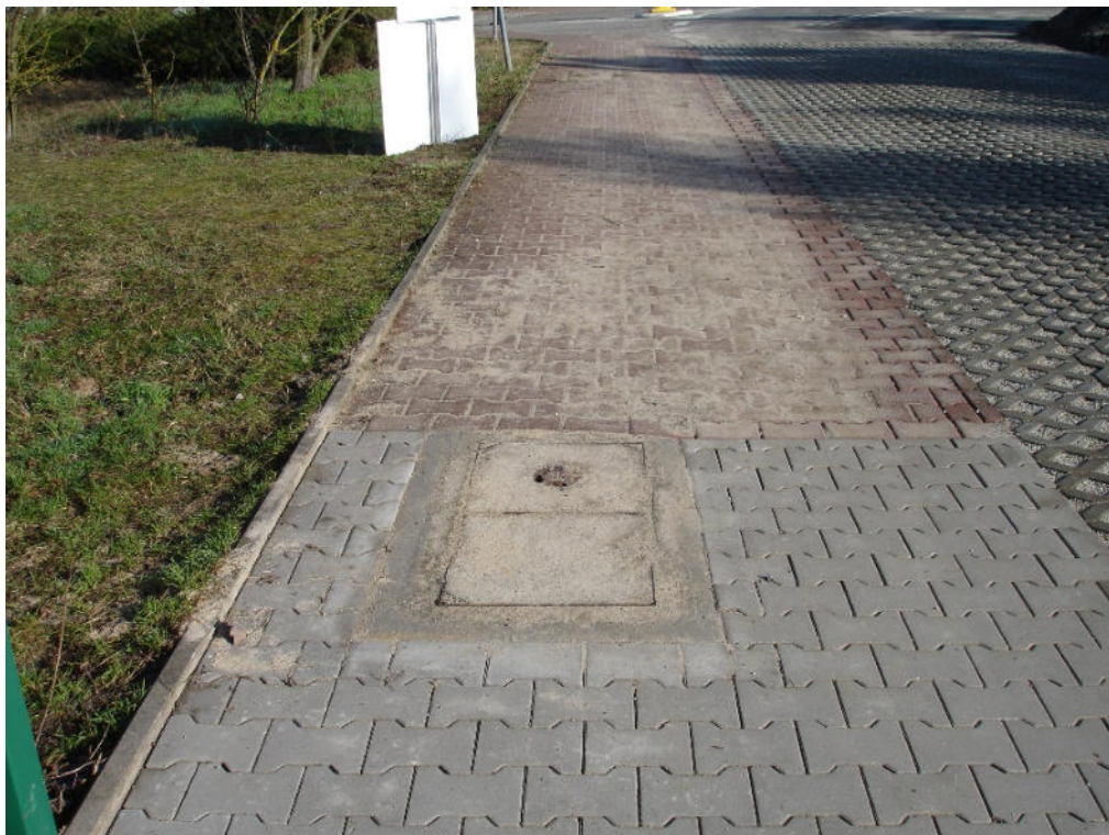
Przykład prostego dowiązania części dla pieszych z kostki betonowej typu „Behaton” bez obrukowania studzienki telekomunikacyjnej z istniejącym chodnikiem, który pozostał ze względu na dobry stan nawierzchni (2024).
