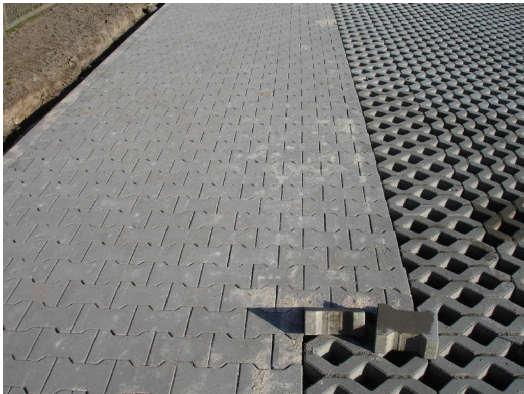
Gotowe elementy górnej warstwy nawierzchni wymagające wypełnienia przed oddaniem do użytkowania. Płyty ażurowe i betonowa kostka typu „Eko-Behton” zostają wypełnione kruszywem z gysu granitowego a szczeliny pomiędzy kostkami betonowymi typu „Behton” drobnym piaskiem (2024).
