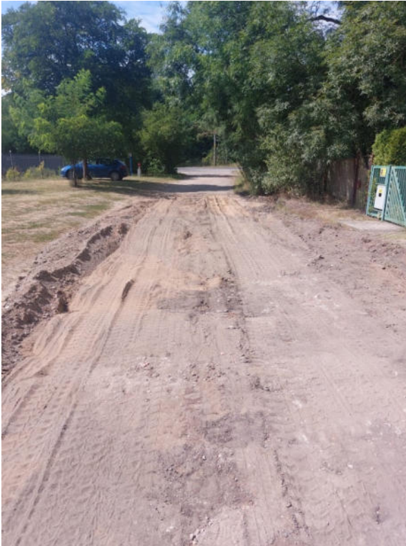
Widok na początkową fazę robót - korytowanie pełnej szerokości i do założonej głębokości. Po prawej przykład zróżnicowania przepuszczalnego podłoża po odspojeniu - przed powierzchniowym dogęszczeniem (2024).
