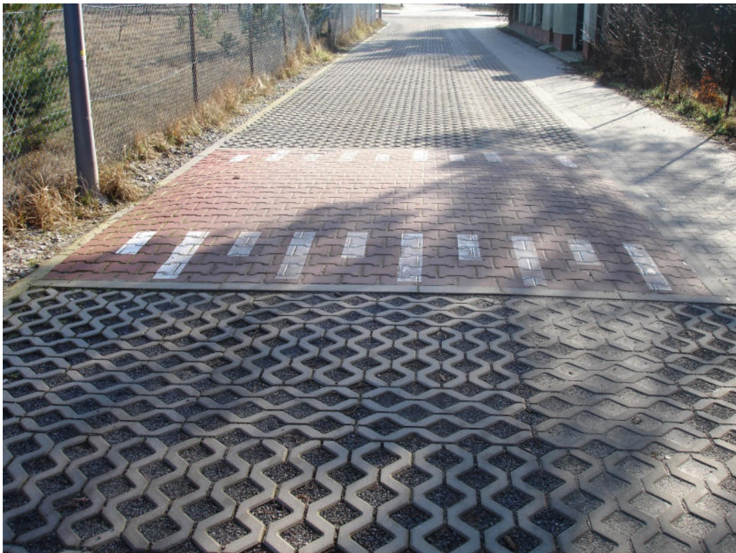
Przykład wykonania na ulicy Anyżowej poduszkowego progu zwalniającego o wymiarach 3,6x3,0m z kostki betonowej typu „Behaton” koloru czerwonego ograniczonej opornikami betonowymi wraz z oznakowaniem poziomym P-25. (2024).
