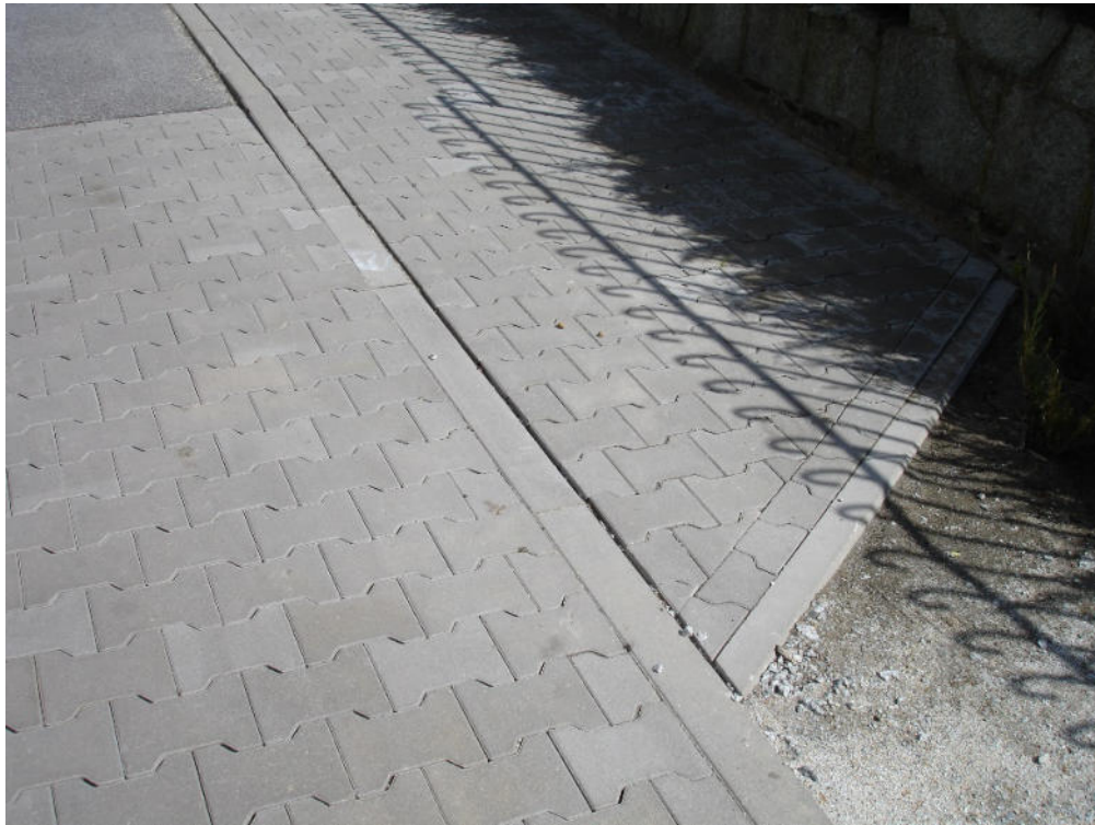
Zastosowanie połączenia skośnego na styku ażurowej części nawierzchni przeznaczonej dla pieszych z kostki typu „Behaton” z istniejącym chodnikiem w pozostałym przekroju ulicy o nawierzchni bitumicznej (2024).
