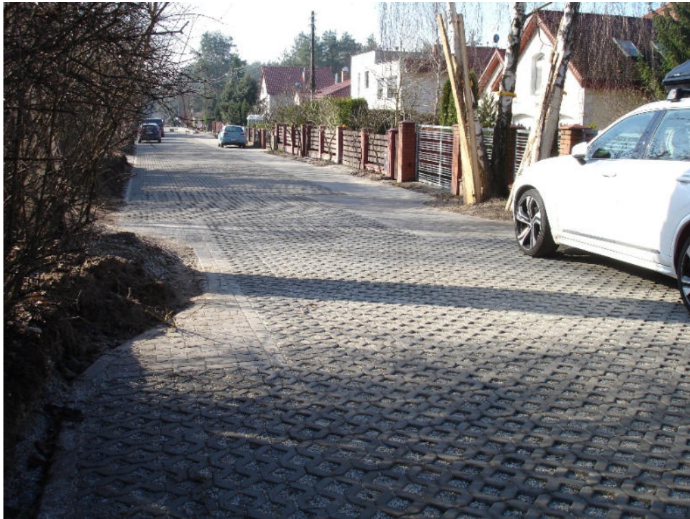
Przykład obustronnego zwężenia jezdni - w części jezdnej z płyt ażurowych oraz w części dla pieszych z betonowej kostki typu „Behaton” (2024).
