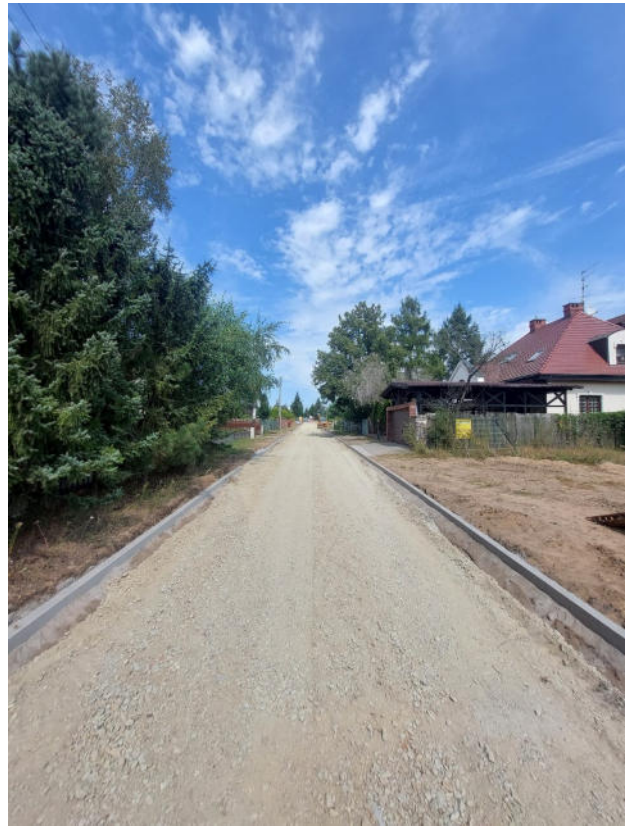
Następna faza robót - rozkładanie podbudowy z kruszywa łamanego oraz zagęszczanie jej warstwami (2024).
