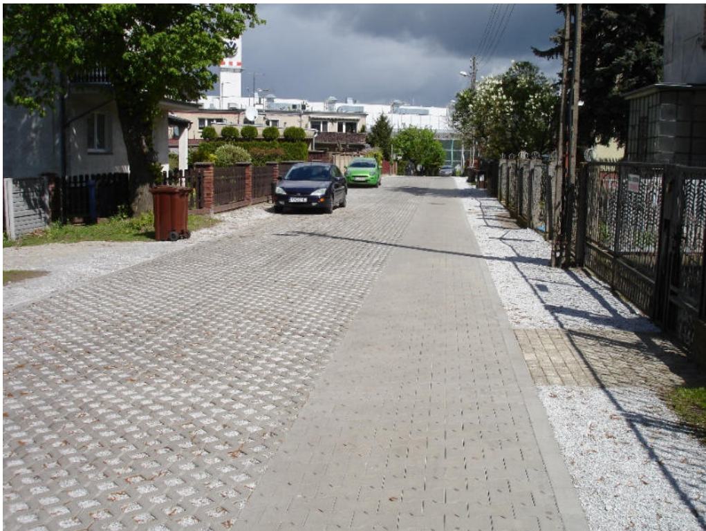
Przykład nawierzchni ulicy na prostej z zastosowaniem tylko kruszywa łamanego - na poboczu szerokości 0,75m oraz szerokości >0,75m w miejscach zjazdów na posesję, gdzie nie było możliwości wykonania zewnętrznego pasa zieleni o minimalnej szerokości 1,0m (2024).
