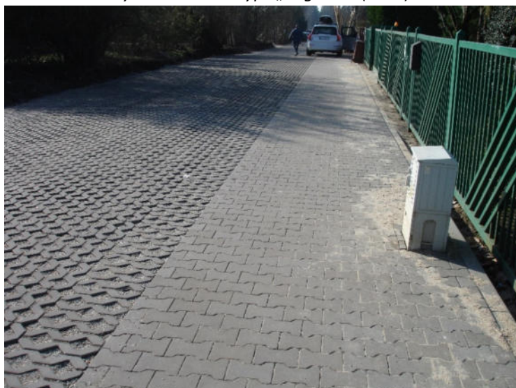
Przykład ułożenia nawierzchni części pieszej z betonowej kostki typu „Behaton” oraz opornika betonowego wokół istniejącej szafki pomiarowo-zasilającej przyłącza energetycznego do posesji (2024).
