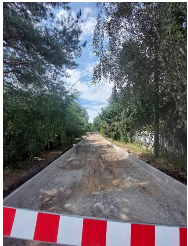
Kolejny etap robót - po wytyczeniu w terenie geometrii ułożenie oporników betonowych na ławie oraz rozłożenie warstwy dolnej podsypki piaskowej gr.10cm. Widoczne po lewej odsłonięte studzienki rewizyjne i pokrywy zaworów sieci do wyregulowania oraz obrukowania kostką betonową w nawierzchni ażurowej (2024).
