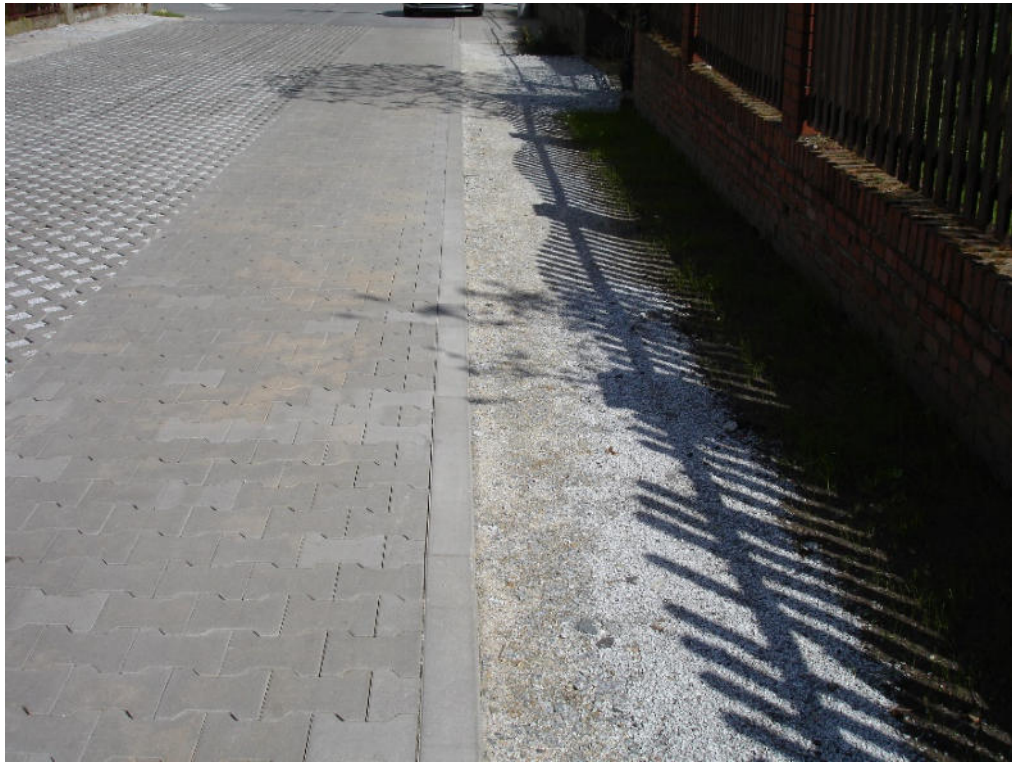
Przykład nawierzchni z płyt ażurowych z zastosowaniem obustronnego pobocza z kruszywa łamanego szerokości 0,75m za opornikiem betonowym. Ulica o pasie drogowym szerszym od 6m i dodatkowym miejscu na zielen przy ogrodzeniach posesji (2024).
