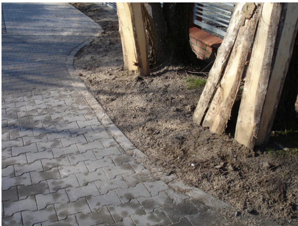
Zastosowanie opornika betonowego o krótszych odcinkach (docinany na miejscu) w celu wykonania luków o małych promieniach (2024).
