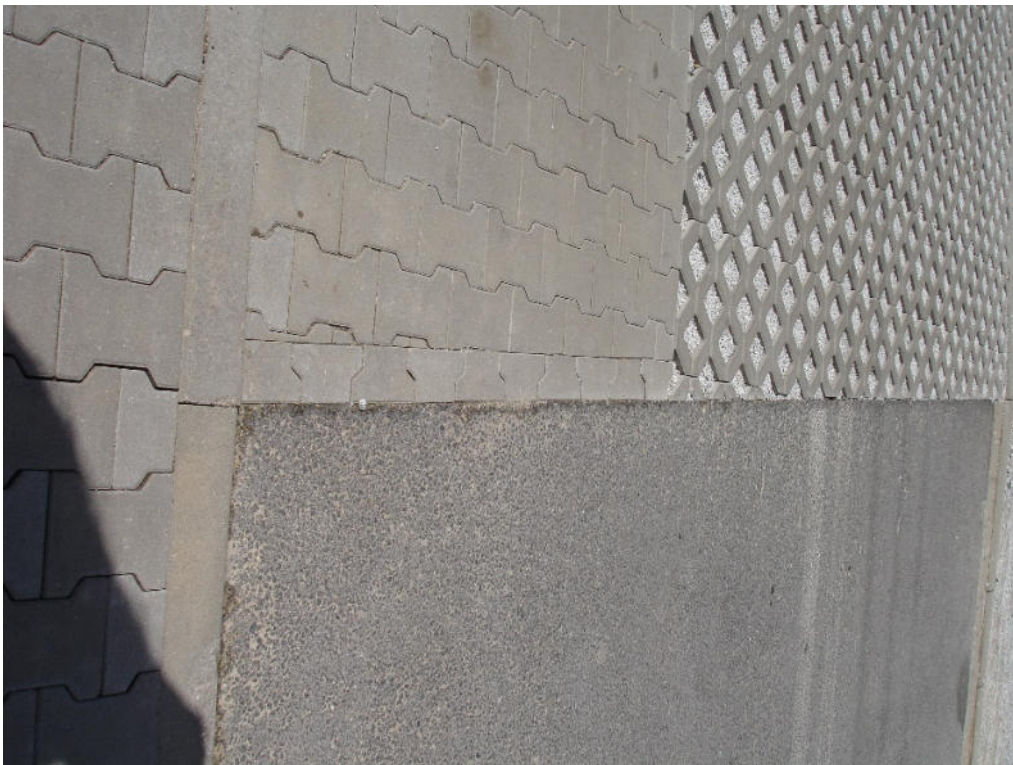
Przykład połączenia nowej nawierzchni ażurowej z istniejącą bitumiczną na styk - bez zastosowania dodatkowego opornika betonowy na ławie (2023).
