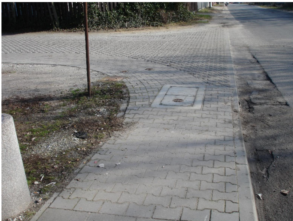
Przykład rozwiązania stosowanego na początkowym etapie programu pilotażowego (rok 2022). Zastosowane płyty ażurowe na łukach nawierzchni przy skrzyżowaniach z istniejącą nawierzchnią (np. bitumiczną) oraz jednostronnym pasem nawierzchni betonowej z kostki typu „Behaton” dla ruchu pieszego. Szerokość 1,40m od strony istniejącego chodnika z płyt betonowych 0,3x0,3m (2024).
