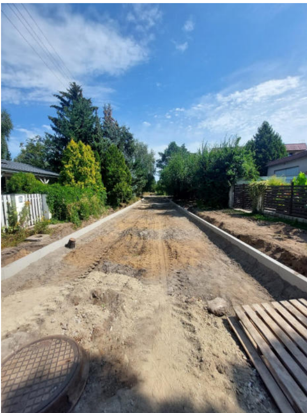
Kolejny etap robót - po wytyczeniu w terenie geometrii ułożenie oporników betonowych na ławie oraz rozłożenie warstwy dolnej podsypki piaskowej gr.10cm. Widoczne po lewej odsłonięte studzienki rewizyjne i pokrywy zaworów sieci do wyregulowania oraz obrukowania kostką betonową w nawierzchni ażurowej (2024).
