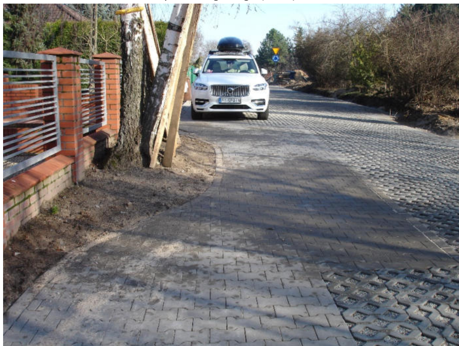
Ułożenie części pieszej nawierzchni z betonowej kostki typu „Behaton” w miejscu zwężenia powstałego poprzez istniejącą zielenią wysoką (2024).
