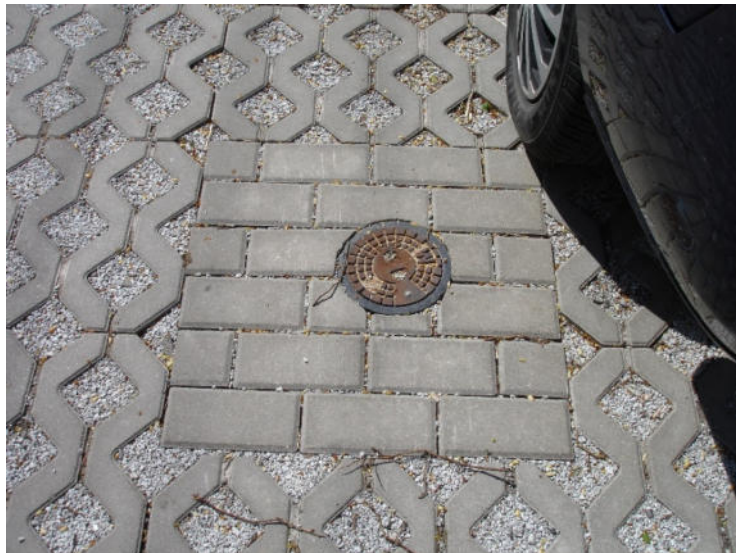
Wybruk 0,6x0,6m żeliwnej pokrywy zaworu studni wodociągowej z betonowej kostki typu „Cegiełka” prostopadle do kierunku jazdy w nawierzchni z płyt ażurowych (2023).
