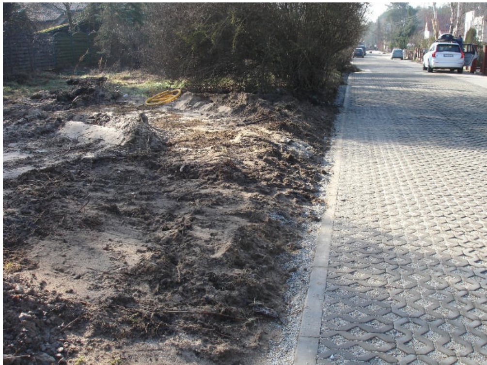
Przykład nawierzchni z płyt ażurowych bez zastosowania dodatkowego pobocza z kruszywa łamanego szerokości 0,75m za opornikiem betonowym ze względu na brak miejsca na poboczu (2024).
