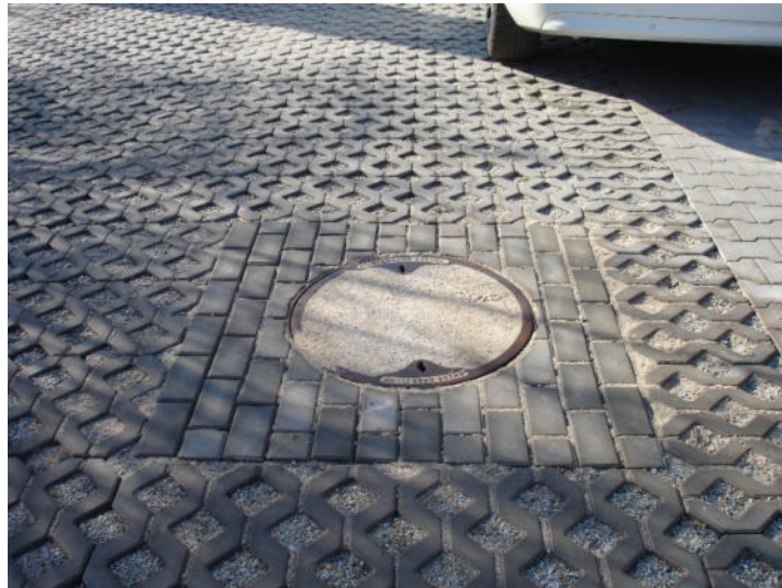
Wybruk 1,2x1,2m betonowo-żeliwnego wjazdu studzienki kanalizacji sanitarnej z kostki betonowej typu „Cegielka” w części jezdnej nawierzchni z płyt ażurowych zgodnie z kierunkiem jazdy (2023).
